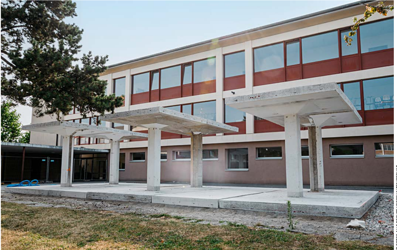
© FOTOS ALLE RECHTE VORBEHALTEN/REBUILT
